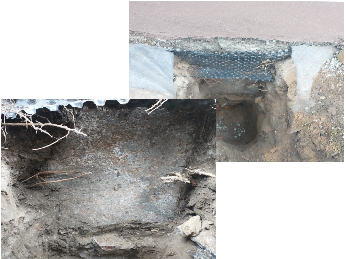
fot. 8. Odkrywka ścian fundamentowych, brak izolacji pionowej i poziomej.
