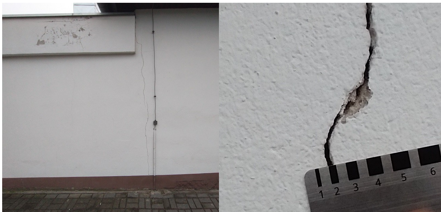
fot. 5. Pionowe pęknięcie na styku części budynku z różnym dachem.
