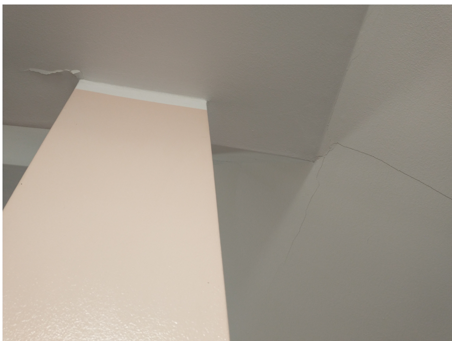
fot. 13. Rysy na stykach płyt gipsowo-kartonowych
