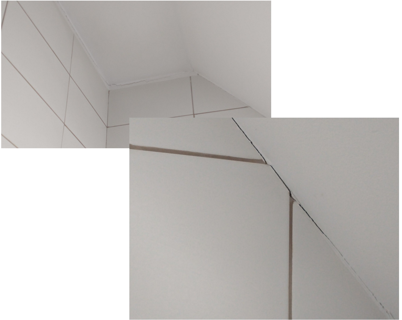
fot. 12. Rysy na styku ściana działowa—sufit w kotłowni.
